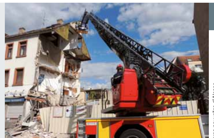
Effondrement d'un mur d'immeuble à Strasbourg (19 août 2014)
