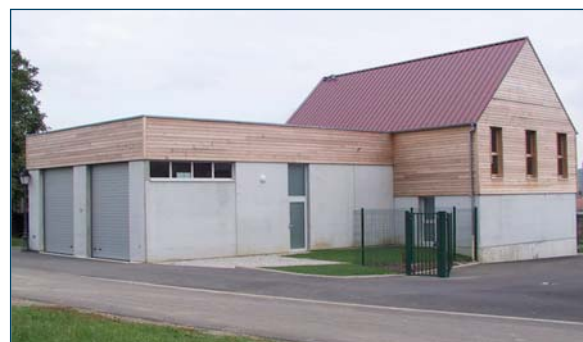
Caserne de Schwindratzheim, inaugurée en 2008 Coût de l'opération pour le SDIS 67 : 280 000 € Terrain cédé à l'euro symbolique par la commune
