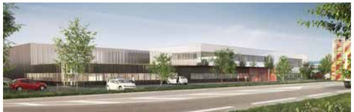
Réhabilitation et extension plateforme logistique du SDIS 67 à Wolfisheim Architecte : REY-LUCQUET - BET : ARTELIA BATIMENT & INDUSTRIE
