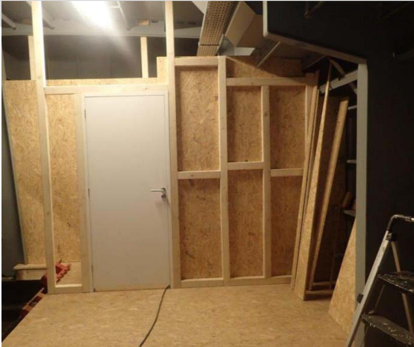
Habillage des murs
